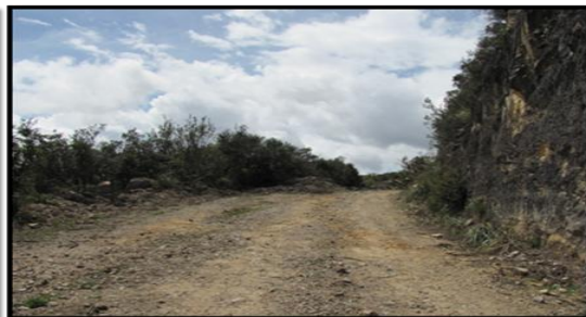
Vía tramo 2 en mayo de 2010
